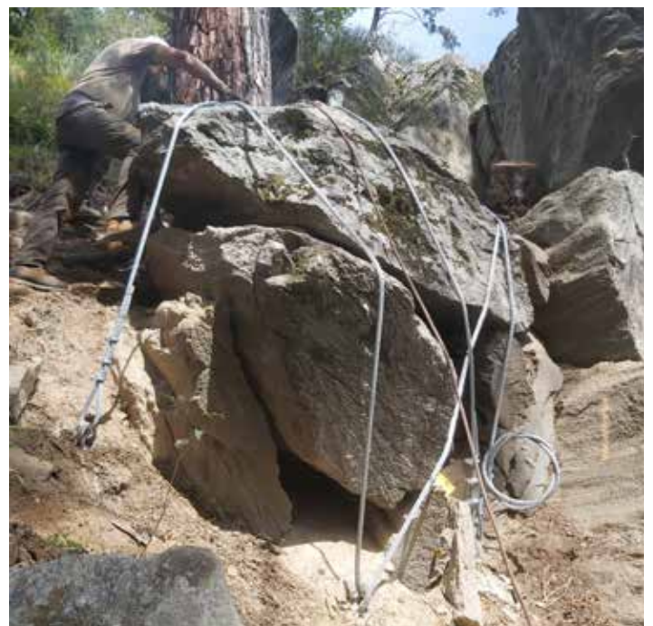
Foto in alto la partenza del nuovo vallo paramassi sopra la Vidorta, in basso imbragaggio dei massi instabili nel bosco sopra la Vidorta.
